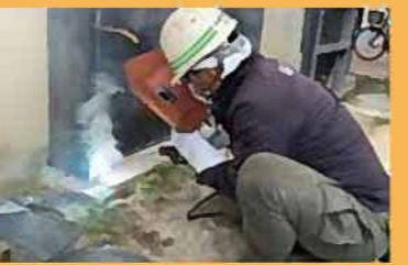
動物が当たって壊した鉄製のカバ舎の扉を溶接機材を使用し修繕します。オレンジのお面は目を保護するためです。
