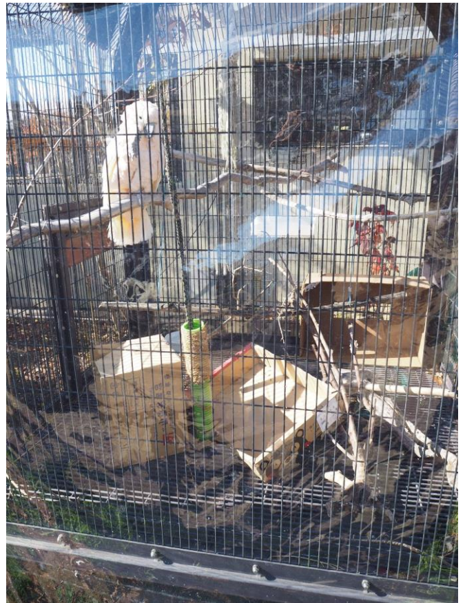
冬の防寒対策で風よけシートを取付中
