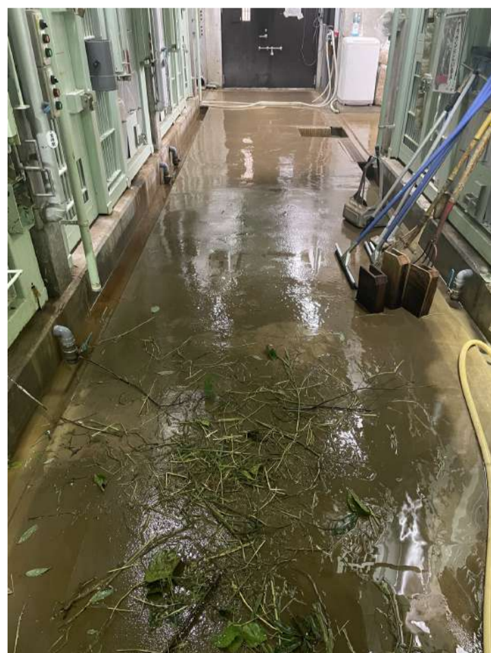
↑ 浸水後の泥だらけのキーパーエリア。手前の草や枝は、通路の上にあるシュートから夜間にゴリラたちが落としたものです。
