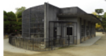
【撤去前の南猛獣舎】
